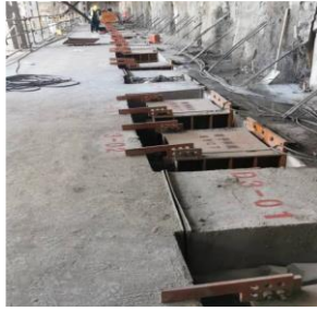
图7 预加力系统安装
