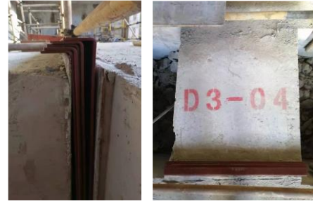
图8 支墩与内圈梁间隙
