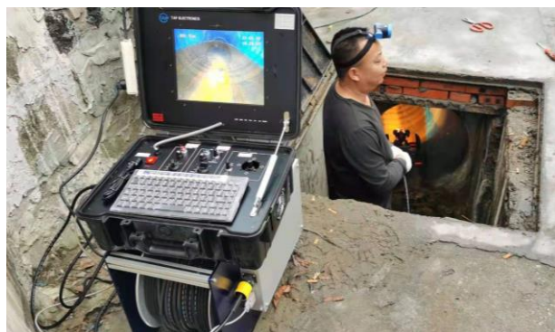
图 12 管道机器人视频检测
